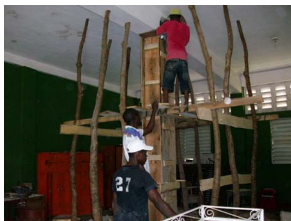
Trabajos de reconstrucción en las escuelas
